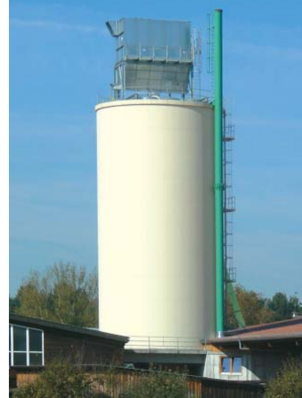
Spänesilo mit Filteranlage
