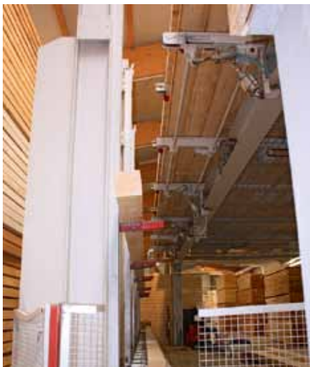
Mit dem Paternoster geht's vom Querlager abwärts auf die Rollenbahn in Richtung Hobelung
