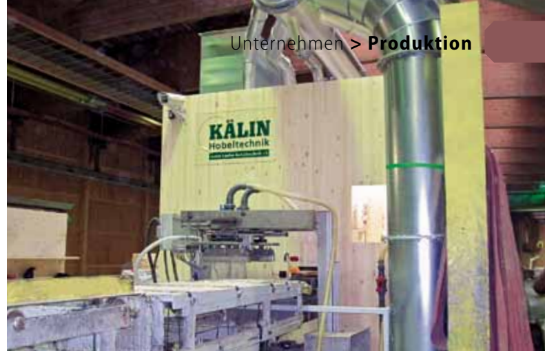
In die bestehende Anlage integriert: Um dem begrenzten Platzangebot gerecht zu werden, wurde die Hobelmaschine 70 cm gekürzt
